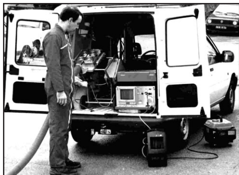
Teleinspecting the pipe Inspección televisiva de la canalización
