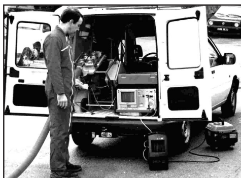
Télé-inspection de la canalisation Teleinspecting the pipe
